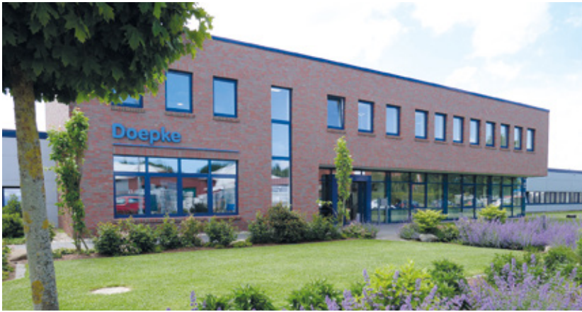
Der Hauptsitz der Doepke Schaltgeräte GmbH in der Stadt Norden, direkt an der Nordseeküste.
